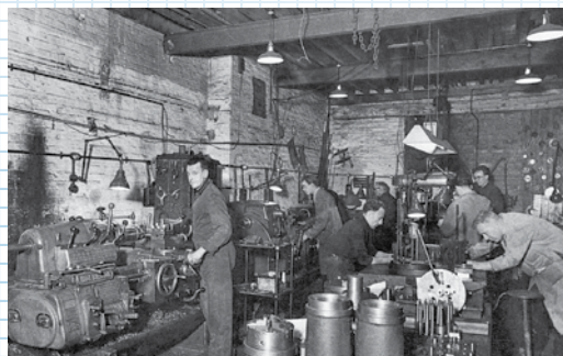
Цех механической обработки введен в эксплуатацию в 1947 г.
